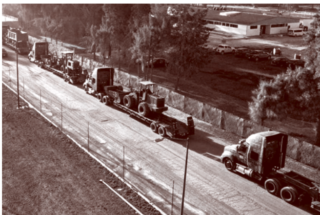
Figura 35: Convoyes militares con máquinas y fuertes equipos de construcción de camino a Quintana Roo.
